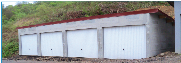
Construction de 4 garages en bout de l'Impasse St Jacques (location).
