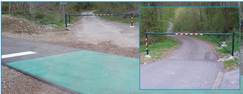
Mise en place de 2 barrières au chemin d'accès à la route forestière de la grande goulette et à la RD 196 (afin de limiter les dépôts sauvages).
