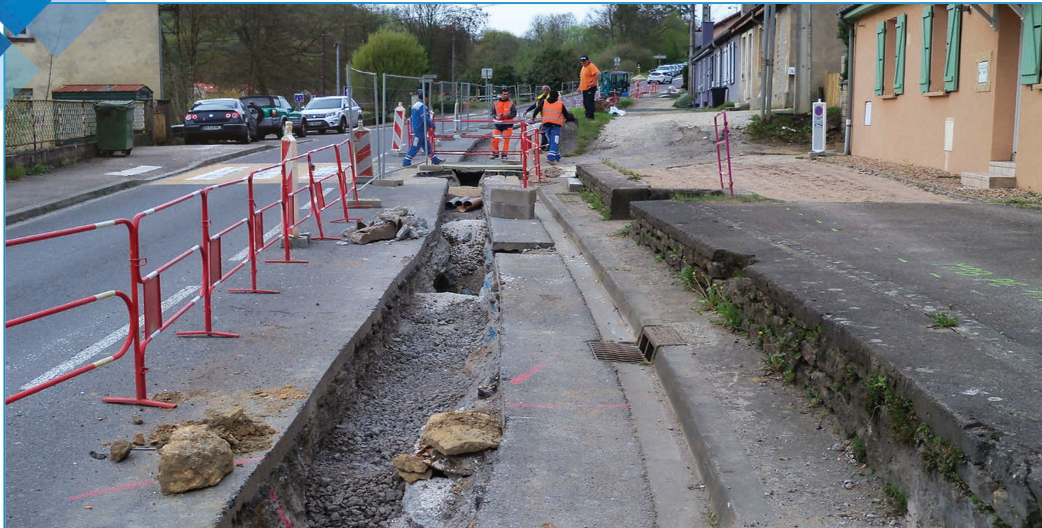
Remplacement de la conduite principale alimentant les riverains de la rue du Moulin ainsi que des conduites plomb afin de mettre ce secteur en conformité avec la loi.
