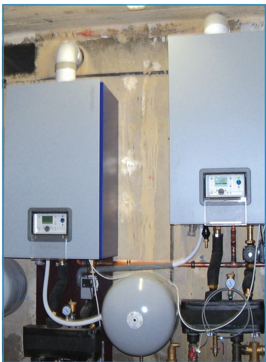
Remplacement de la chaudière Mairie et salle des fêtes HAUCOURT par 2 chaudières plus performantes et moins consommatrices d'énergie.
