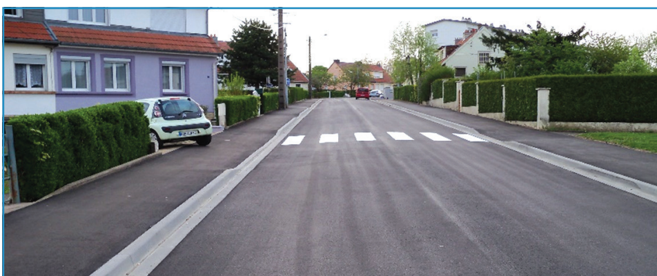
Remplacement des enrobés sur la voirie, trottoirs ainsi que des bordures sur la 1ère moitié de la rue de la Seine.
