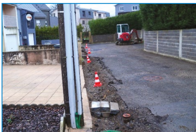
Réfection de l'Impasse (côté droit) Allée de la Somme
