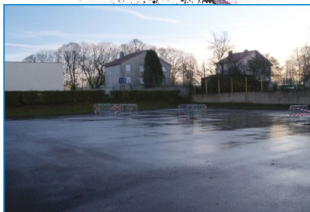
Remplacement enrobés Cour de l'Ecole élémentaire du groupe scolaire Jean Moulin + Plantation d'arbres par les Services Techniques
