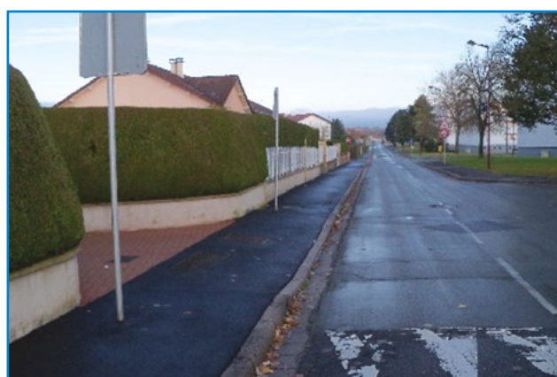
Réfection trottoir côté droit (en descendant rue de la Meuse)
